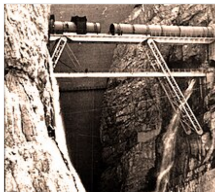
Il nuovo ponte canale in acciaio in fase di costruzione
