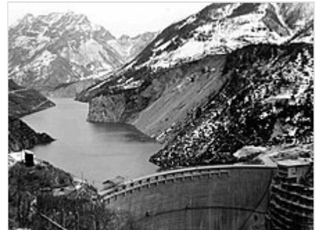
Il lago del Vajont, con il segno dello scivolamento della frana del 1960. Si nota la "punta del Toc", con il "Castelletto"
