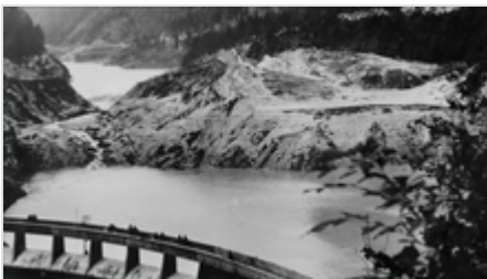
La frana del lago di Pontesei, da poco caduta, e il lago in abbassamento di quota
