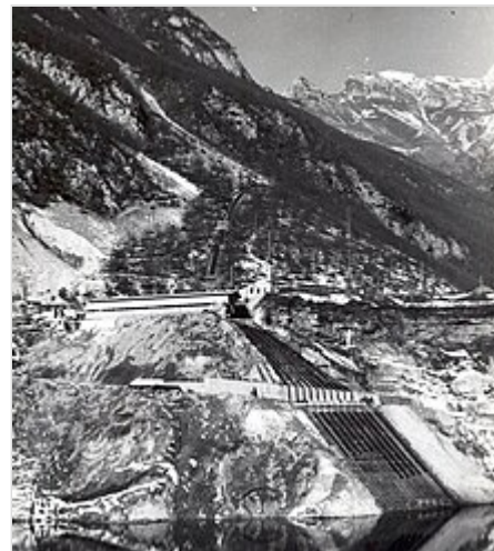
L'impianto di pompaggio in riva al lago del Vajont
