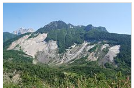
L'area della frana, i cui detriti costituiscono il fondovalle
